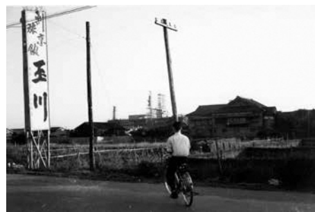
1958(昭和33)年に撮影された「玉川」 奥には建設中の旧市役所が見える。
